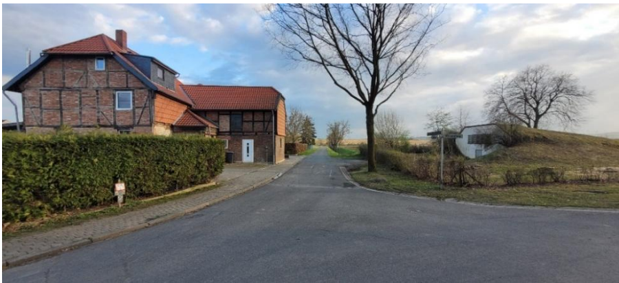
Abb. 4: Vorhandenes Wasserwerk und angrenzende Bebauung
